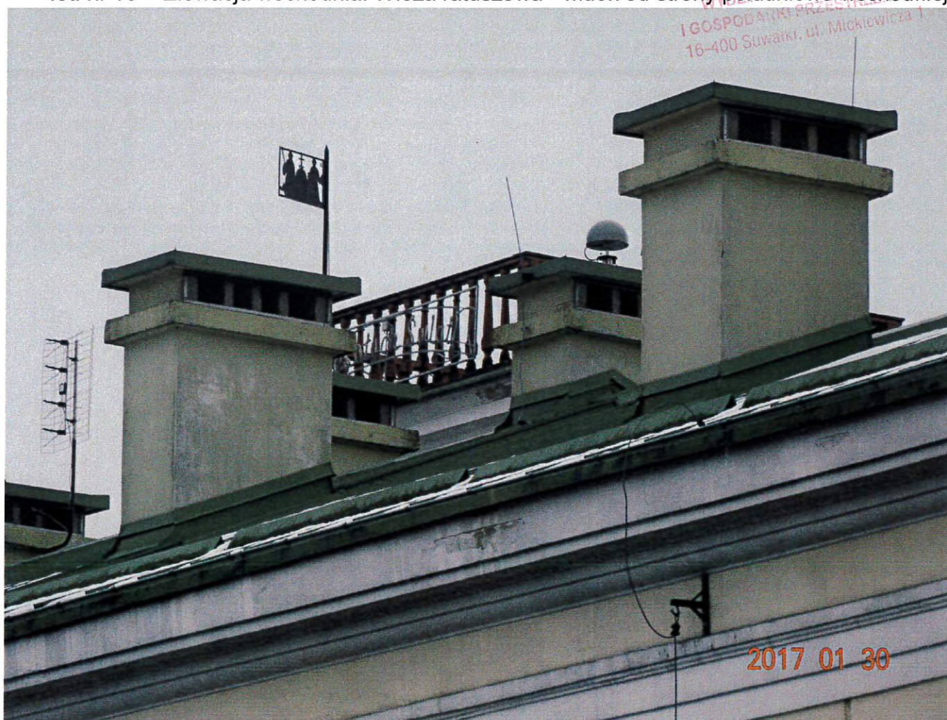
fot. nr 11 – Elewacja północna. Kominy z otworami wentylacyjnymi.
